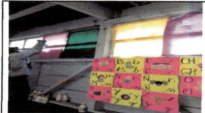
Foto 8: Sustitución de vidrios.
